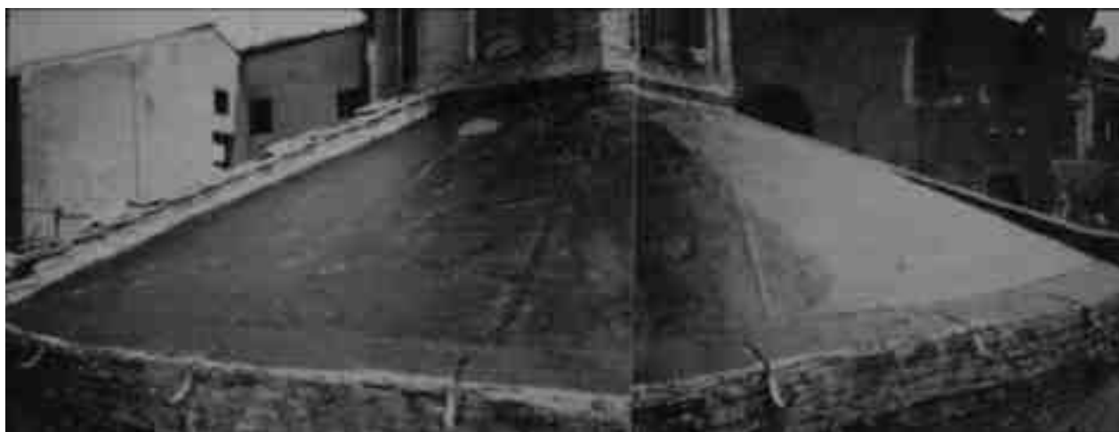
Fig. 11. Riposa del manto di copertura con interposto strato impermeabilizzante e disposizione delle cicogne per l'installazione dei canali di gronda – intervento del 2000 – Fotografie dell'archivio della Soprintendenza Archeologica di Roma
