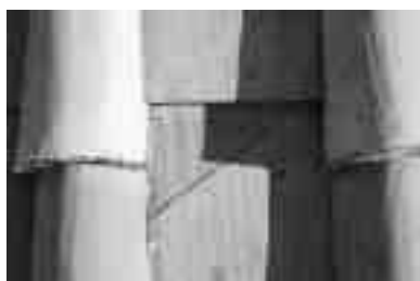
Rottura accidentale di un elemento e rottura per il passaggio di impianti
