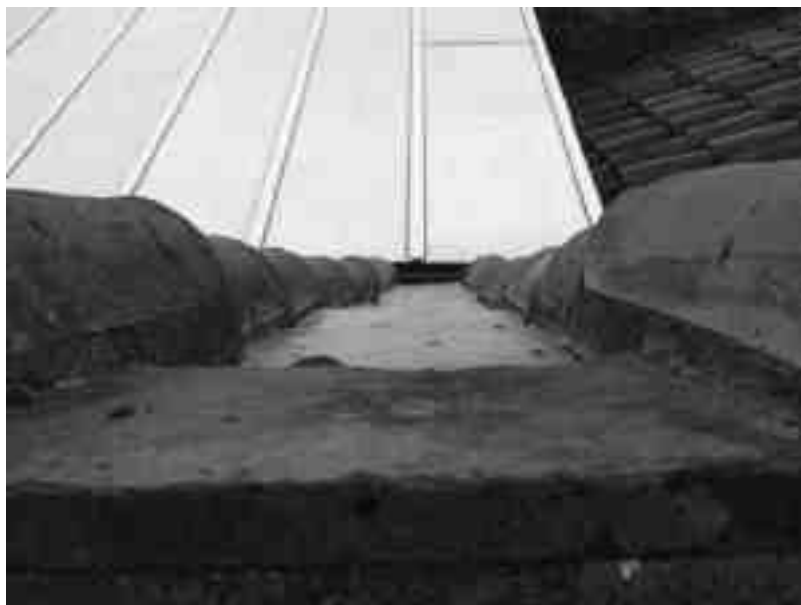
La conca tra la copertura del portico e la tettoia di riparo della fontana del cortile
