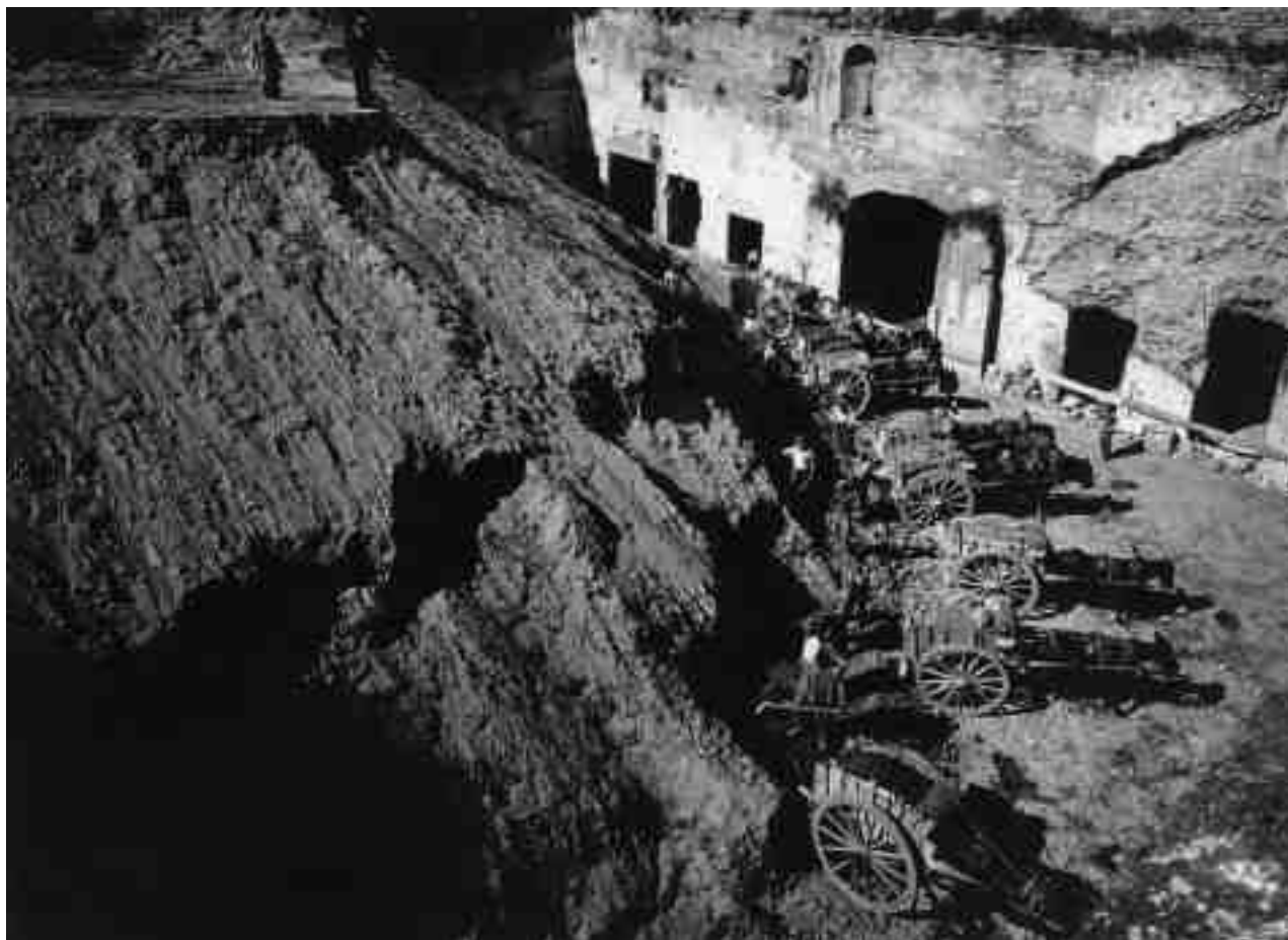
Gli sterri del livello inferiore della Domus Augustana eseguiti negli anni Trenta, da: Soprintendenza Archeologica di Roma, Gli scavi sul colle Palatino , Electa, 1997
