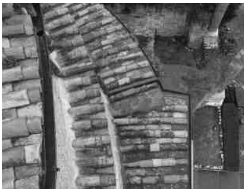
Fig. 6. a) Copertura del Tempio di Romolo. A destra, in prossimità della muratura della Basilica dei SS. Cosma e Damiano, è visibile la botola di accesso alle falde di coperture; b) Veduta dei tre livelli di falda della copertura della Rotonda
