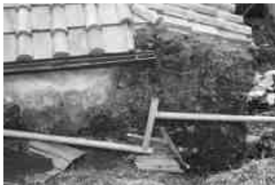
Lato nord dell'edificio
