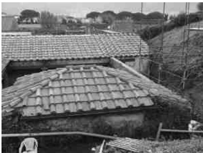
Livello del terreno a ridosso della parete P110
