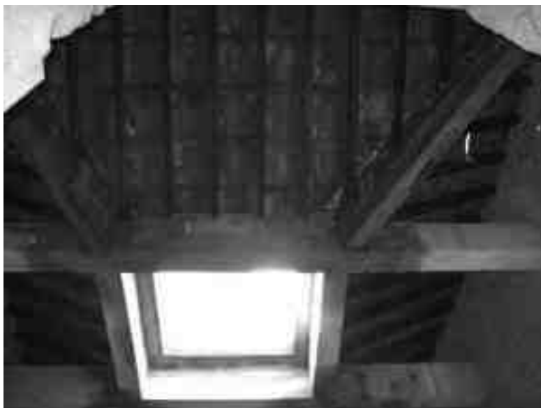
Copertura dell'ambiente M
