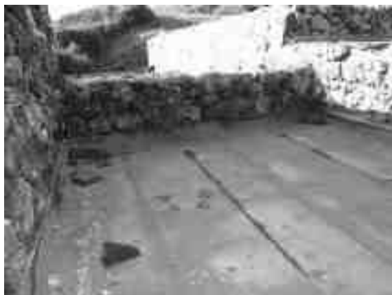
Copertura dell'ambiente F: il deposito di terriccio favorisce la crescita di vegetazione
