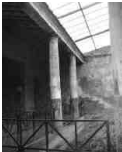
Copertura spingente sulla parete P18
