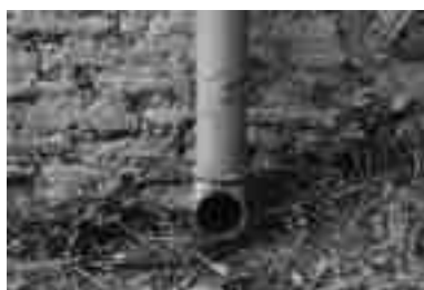
Figura 10. Scarico a terra del pluviale in corrispondenza dell'Amb. 8
