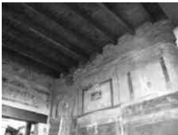
Dettaglio di un ambiente interno
