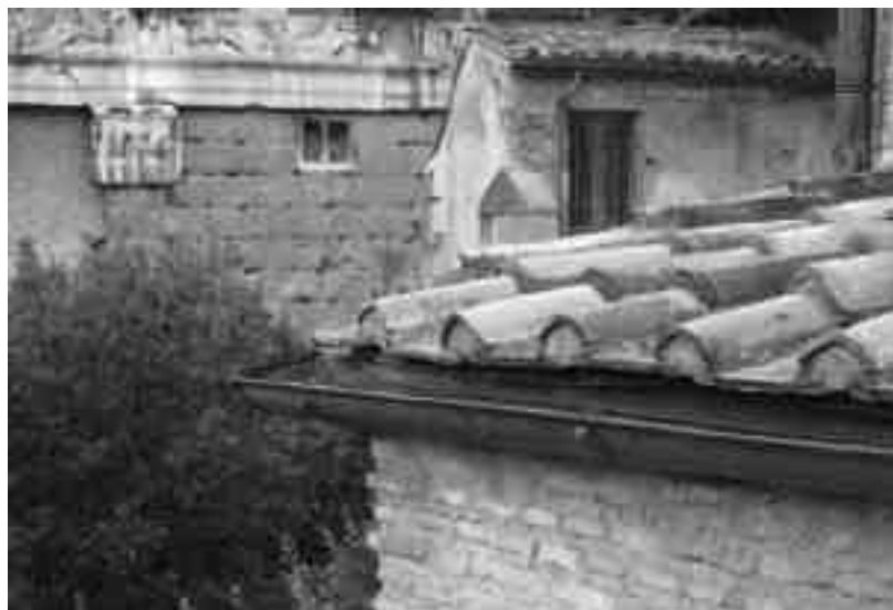
Fig. 10. a) Particolari dei canali di gronda soggetti a ristagni di acqua e terriccio e crescita di vegetazione, b) disallineamento del canale dovuto al peso dell'acqua e del materiale terroso
