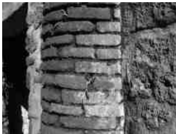
Ambiente I completamente contro terra
