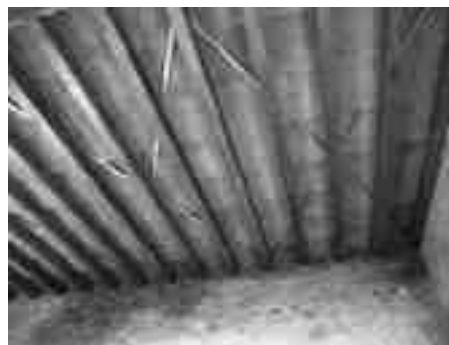
Copertura dell'ambiente P
