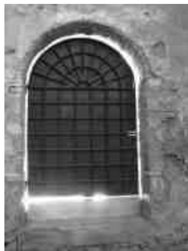
Figura 6. la stessa finestra dopo l'intervento di chiusura (foto aprile 2011)
