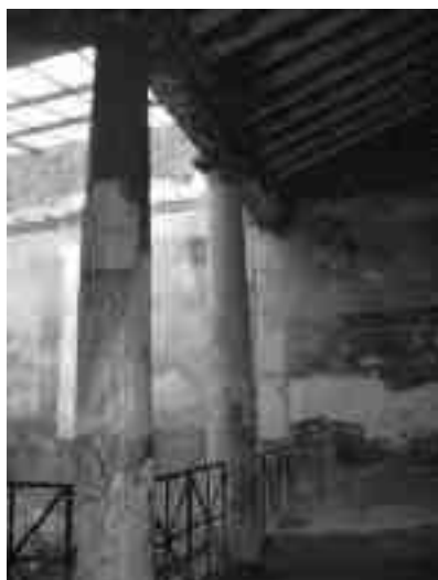
Copertura spingente sulla parete P19
