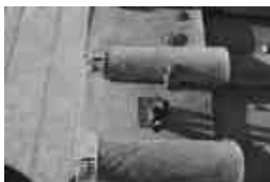
Rottura accidentale di un elemento e rottura per il passaggio di impianti
