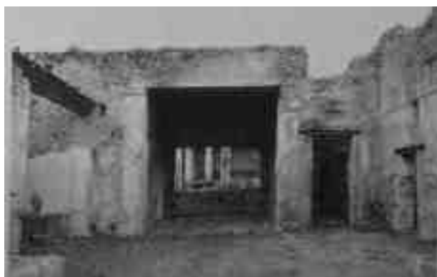
Stato di fatto prima dei restauri: ingresso, vista della corte G
