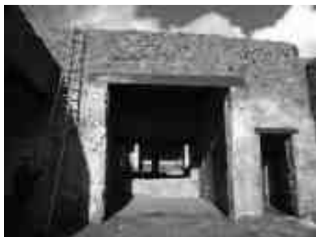
Architravi delle pareti P21 e P24
