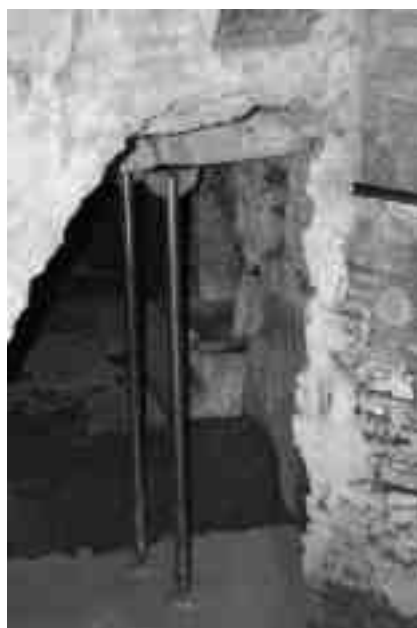
Figura 7. I puntelli a sostegno dell'architrave del vano di accesso alla cripta (amb. 2)
