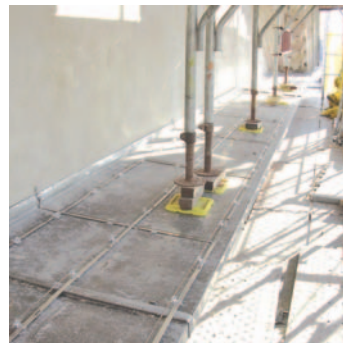
29 (grande). Applicazione, sull'intonaco bonificato, di un intonachino costituito da calce aerea, pietre macinate e terre coloranti con pigmentazione concordata con la Soprintendenza.
