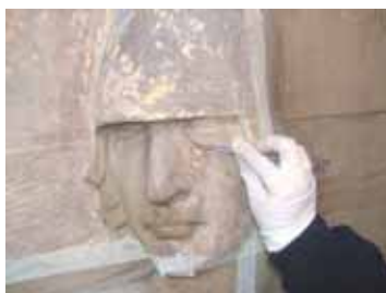
12,13. Momenti delle prove di pulitura dei bassorilievi con rimozione della pellicola pittorica soprammessa
