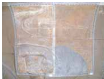
12,13. Momenti delle prove di pulitura dei bassorilievi con rimozione della pellicola pittorica soprammessa
