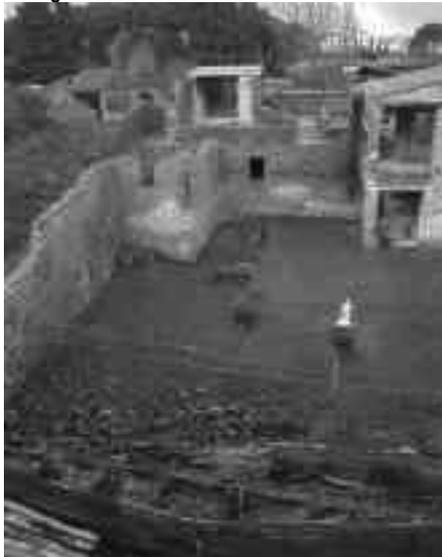
Vista del cortile settentrionale (AC); si notano gli ambienti AB1 e AI1 a piano superiore e il muro di contenimento crollato per la spinta del terrapieno.
