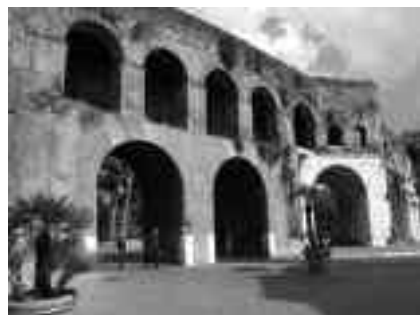
Fig. 2. Il fronte interno di Porta Pinciana
