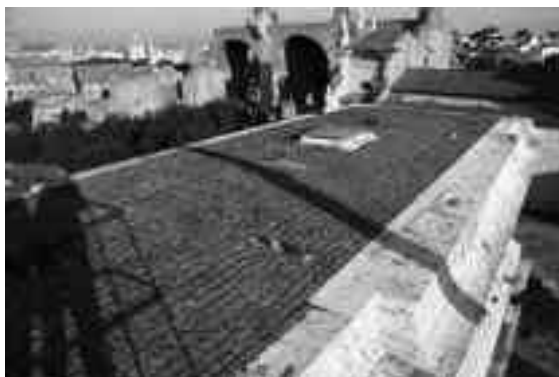
Copertura: vista Sud-Est
