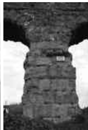
Prospetto Sud-Ovest. Pilastro n. 54
