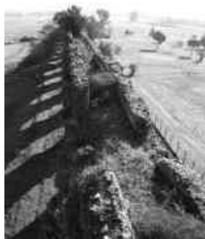
Foto 2. Vista dall'alto dell'acquedotto; si nota la distanza ravvicinata della recinzione di sicurezza
