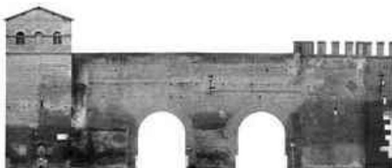
Fig. 5. Fotopiano esterno di parte della Porta Pinciana (rilievo SAT Survey)
