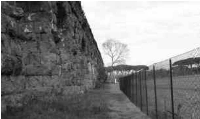
Foto 1. La recinzione di sicurezza in prossimità del prospetto Nord-Est
