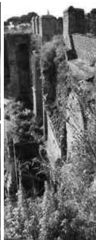
Vista del camminamento (livello 2) dalla torre T4
