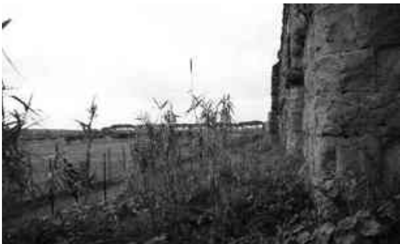
Foto 3. Arbusti in prossimità del prospetto Sud-Ovest
