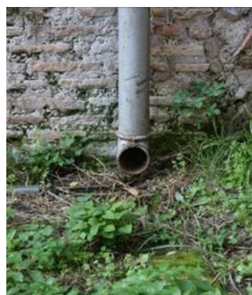
Roma, Foro Romano, Tempio di Romolo, inefficienza dei sistemi di allontanamento delle acque per intasamento dei canali di gronda e dispersione di acque al suolo non controllate.
