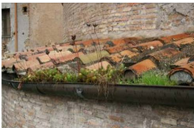
Roma, Foro Romano, Tempio di Romolo, inefficienza dei sistemi di allontanamento delle acque per intasamento dei canali di gronda e dispersione di acque al suolo non controllate.
